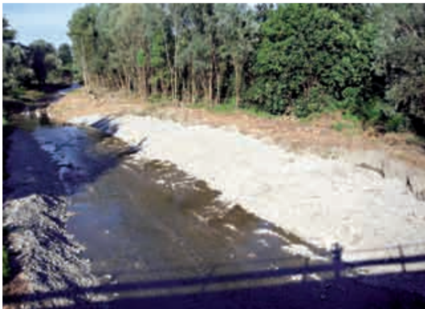
Un'immagine del Tresinaro dopo l'intervento di "pulizia"
